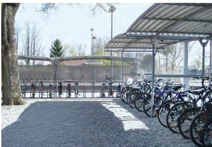
Abri unilatéral, disposition d'angle. Toiture en profilés de tôle d'acier.
